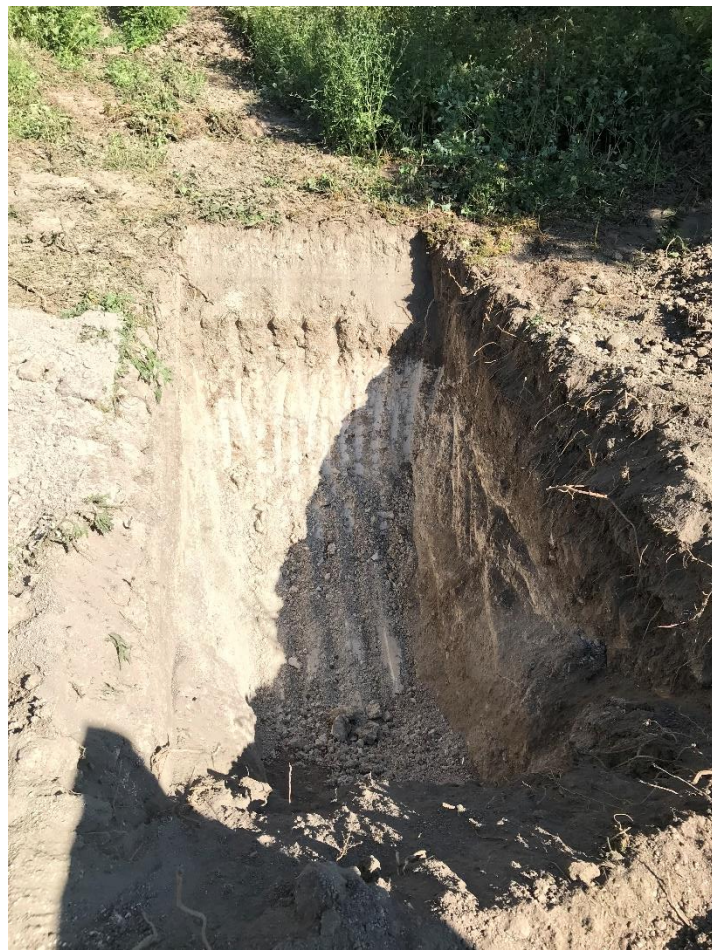
Photo en fin de sondage à la pelle.
