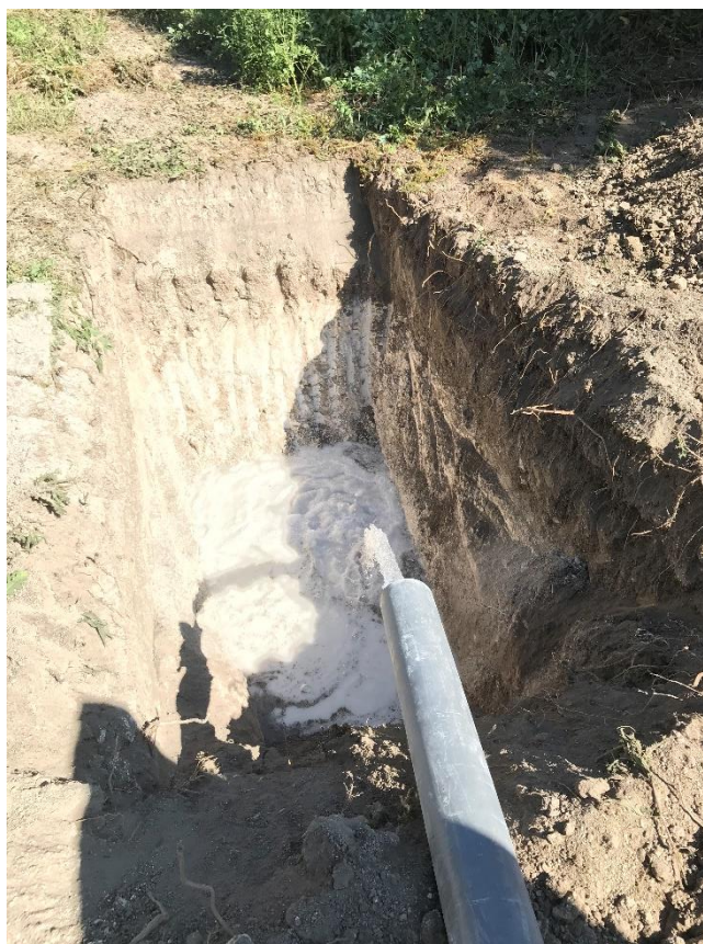
Photo de remplissage de la fosse en eau
